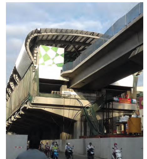
Line 2A, Hanoi Metro.
