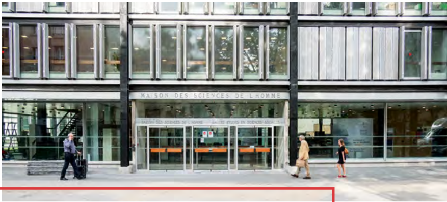
Left: The office of the Fondation Maison des Sciences de l'Homme (FMSH) in Paris, France. (Photo courtesy of the authors.)
