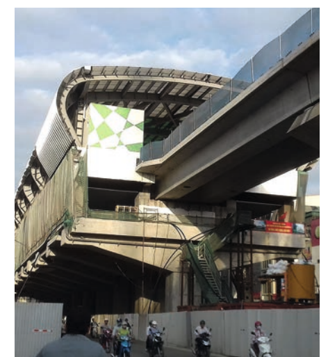
Line 2A, Hanoi Metro.
